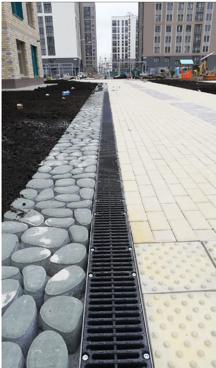
г. Екатеринбург, жилой комплекс
