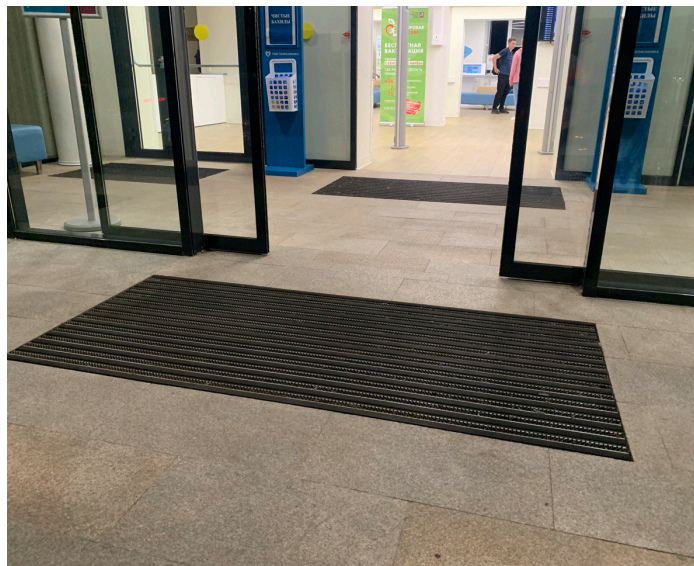
Установка модуля в приямок
