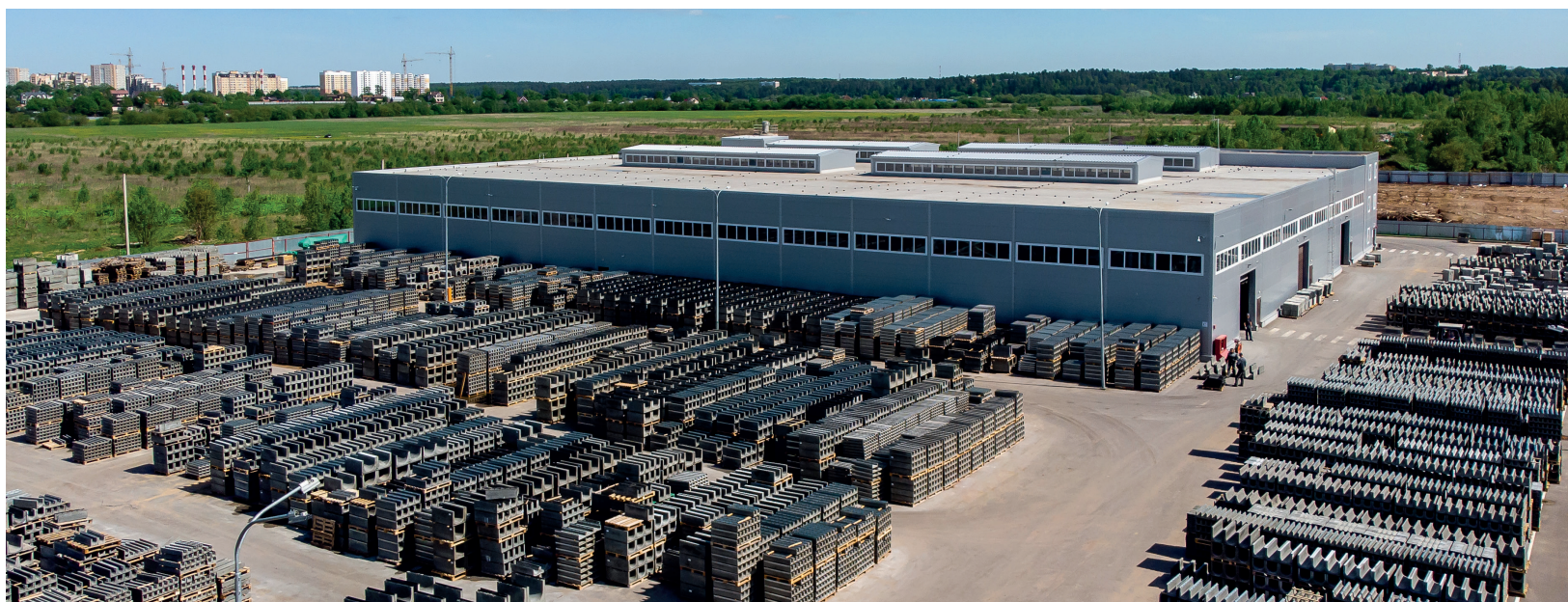
Производство и склад: г. Звенигород
