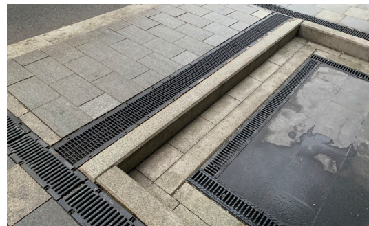
г. Москва, ул. Большая Полянка
