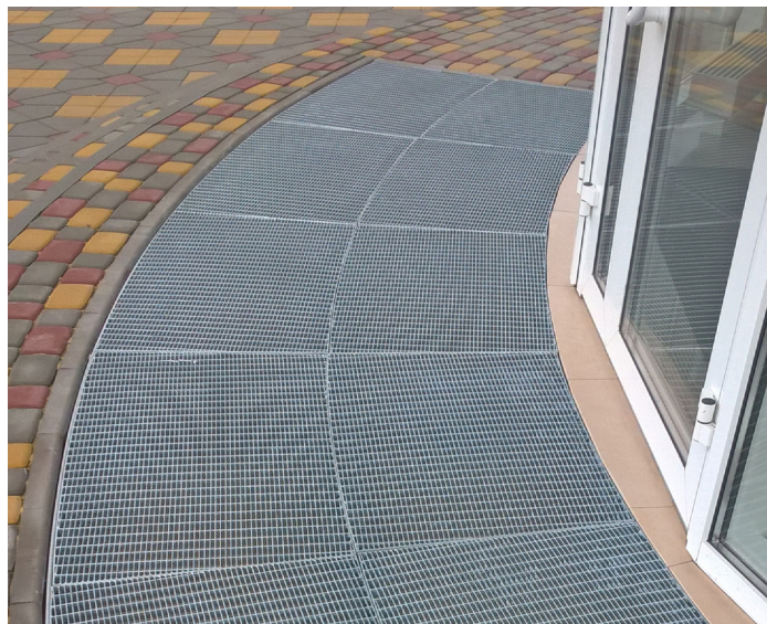
Установка модуля на металлическую конструкцию
